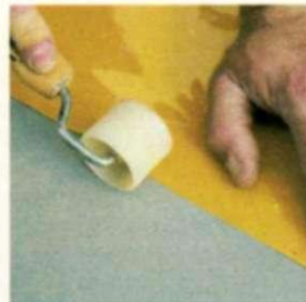
2. Se alinean juntas las dos piezas y se pasa por encima el rodillo de empapelar paredes.
