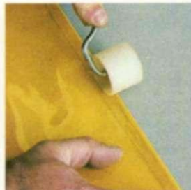
3. Se aplica adhesivo a uno de los lados de la junta y se dobla para formar un espesor doble. Se vuelve a pasar sobre ella el rodillo.
