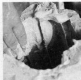
5. Se refuerza el interior de las juntas añadiéndoles yeso.
