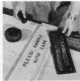
9. Sobre los listones que refuerzan la caja se ponen, muy apretados, unos flejes. En el exterior de la caja, claramente visibles, se ponen las instrucciones para su manejo y transporte.
