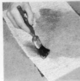
3. Se pone una lámina de «mat» de fibra de vidrio sobre la capa de gel. Se mezcla y se cataliza resina que se aplica a pincel para que penetre en el «mat».
