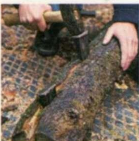
2. Se coloca una segunda cuña en la parte de arriba de la madera, alineada con la primera longitudinalmente.
