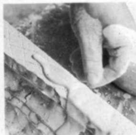
3. Se calza una de las secciones con los bordes de las juntas hacia arriba y en horizontal. Se echa mezcla de yeso fresca a lo largo de cada junta.
