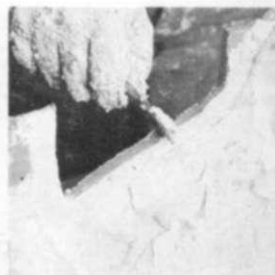
10. Se limpia el borde superior de la pared de arcilla con una espátula.
