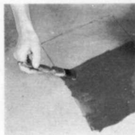
2. Se mezcla y se cataliza la resina para la capa de gel, que se aplica a pincel sobre el área marcada, dejándola que se endurezca.
