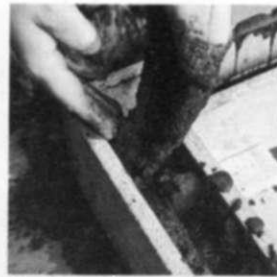
5. Se sigue echando hormigón hasta llenar por completo el molde.
