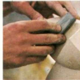
3. El acabado de la superficie se hace con piedras abrasivas, con las que puede trabajarse en húmedo y en seco.
