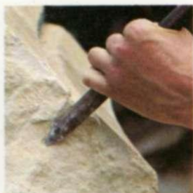
3. Se continúa el desbaste con un punzón, que se mantiene en ángulo agudo sobre la piedra, haciendo cortes paralelos de arriba abajo de la superficie.
