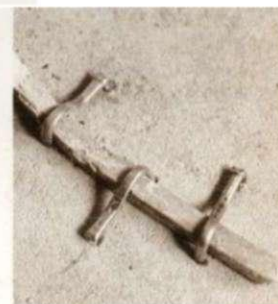
3. Debe quedar anclada sobre la base con clavos que, con un martillo, se doblan sobre el aluminio.
