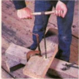
2. Con una barrena en la posición adecuada se perforan verticalmente los dos bloques de madera.
