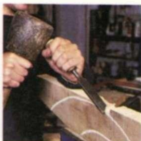
2. Siguiendo la línea marcada se utiliza un escoplo para quitar la madera sobrante entre los cortes de la sierra.
