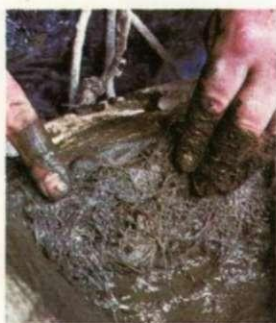
5. Aplicar una capa de refuerzo de «mat» de fibra de vidrio empapado en hormigón. Se cubre el molde con sacos húmedos y se deja fraguar.
