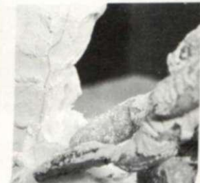
9. Se pone una capa gruesa de yeso contra la tira de latón, manteniendo limpio el borde de la misma, que debe estar claramente visible.
