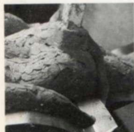
2. Las tiras de chapa se colocan de forma que puedan separarse fácilmente las distintas secciones del molde.
