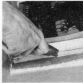
6. Cuando la resina está parcialmente endurecida, se recorta el borde con una cuchilla afilada para dejarlo neto y limpio.
