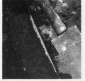
6. Para asegurar una distribución uniforme del hormigón, se golpea con un mazo el molde en todo su contorno.
