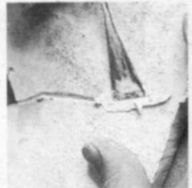
5. Se rellena la entalladura con yeso que se aplica con una espátula. Una vez fraguado el yeso, se pulimenta la superficie.
