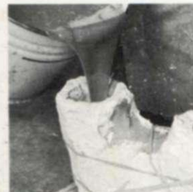
21. Se funde una cantidad suficiente del producto de vinilo para moldes y se cuela dentro de la cubierta a través del bebedero, llenándolo hasta el borde.
