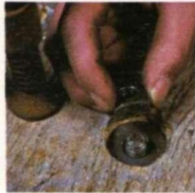
6. Se mete desde abajo el perno a través del taladro que se ha hecho y se le inserta la arandela y la tuerca.
