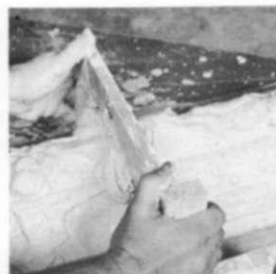
5. Cuando las capas de yeso han alcanzado el suficiente espesor, se aprieta la plantilla contra el listón y se arrastra a lo largo de la forma.
