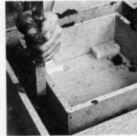
2. Se echa en el molde una capa de mezcla de hormigón espesa y se pudela con una vara o listón para que no se hagan burbujas de aire.
