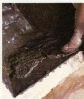
4. Se aplica a presión sobre la capa de cemento aluminoso una capa de 6 mm. de hormigón espeso, añadiendo más cantidad en los rincones.
